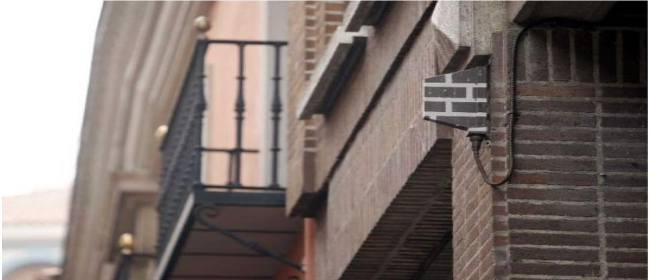
Una picoantena simulada para mimetizarse con la pared.
