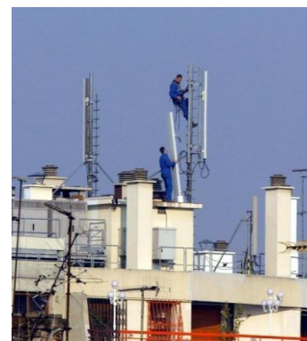
Des techniciens installant des relais téléphoniques sur le toit d'un immeuble parisien en mars 2003
