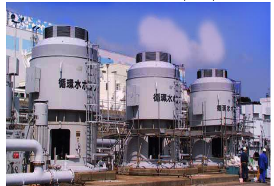
Pompes verticales géantes d'eau de refroidissement des réacteurs de la centrale nucléaire de Fukushima Daiichi lors d'une maintenance. (Photo TEPCO)
