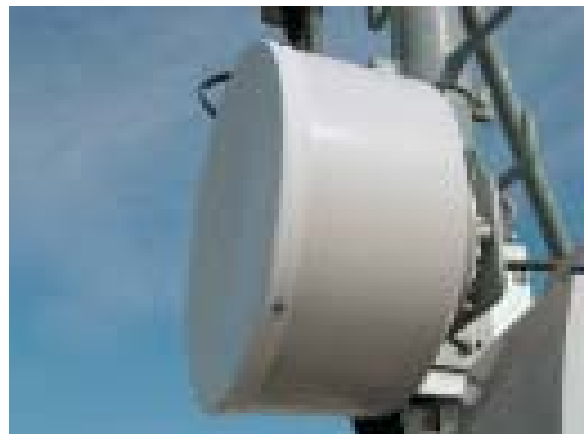
Antenne hertzienne qui permet le pilotage à distance des antennes et équipements.
