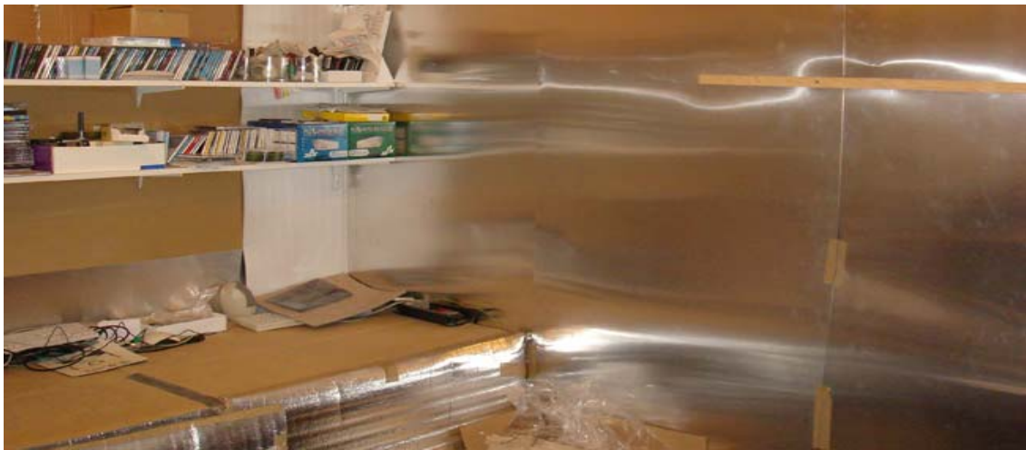
aluminiumfolie tegen de muren, plafon en vensters (geen daglicht meer voor Eric), metallische deur
