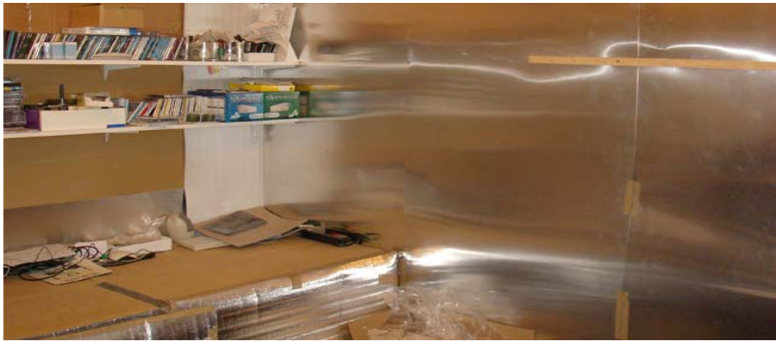
Aluminium contre les murs, fenêtres occultées et portes métalliques
