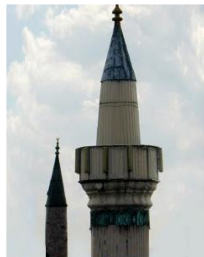
Alminar con antenas enlace (ajt.Next-up)
