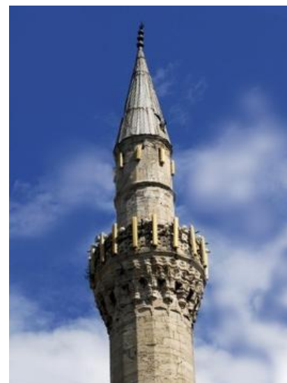
Alminar con antenas enlace (ajt.Next-up)
