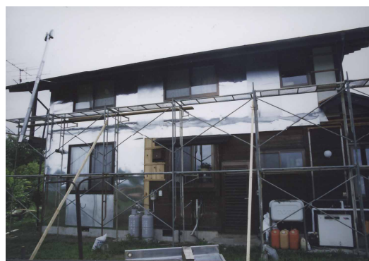
写真 2: 携帯電話電磁波を防ぐための電磁波対策工事。アルミ板を貼ってアースをとった
