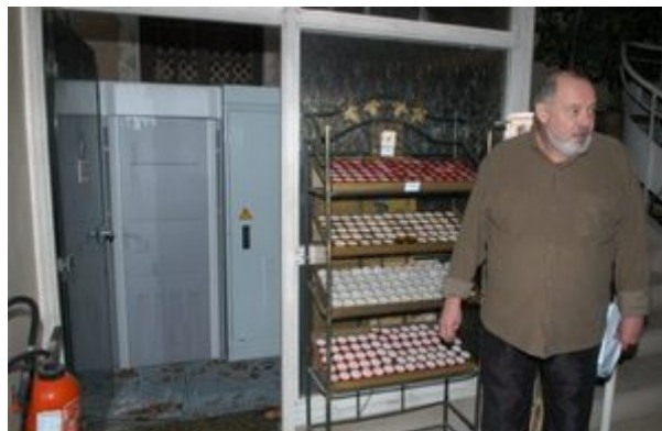
Les installations de Bouygues joutent la chapelle des Lumières, juste derrière les cierges.
