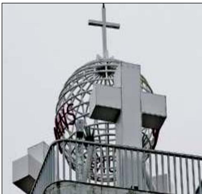
**Next-up: dettaglio delle 3 antenne di telefonia mobile dell'operatore Vodafone che sono camuffate nei 3 incroci del campanile della chiesa di Fatima.**
