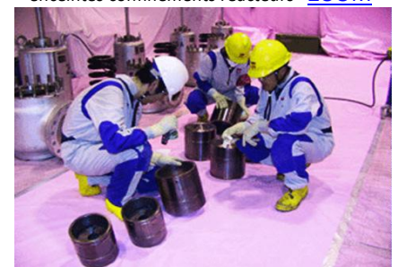
Fukushima : Inspection des soupapes et valves de sécurité des cheminées de décompression
