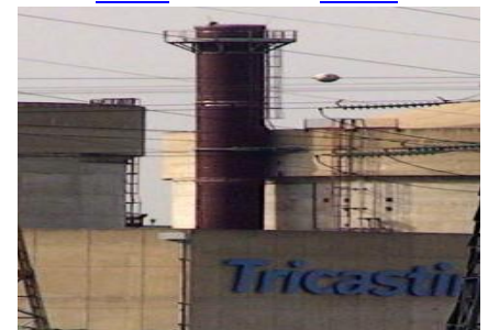
CN du Tricastin : cheminée décompression enceintes confinements réacteurs - ZOOM
