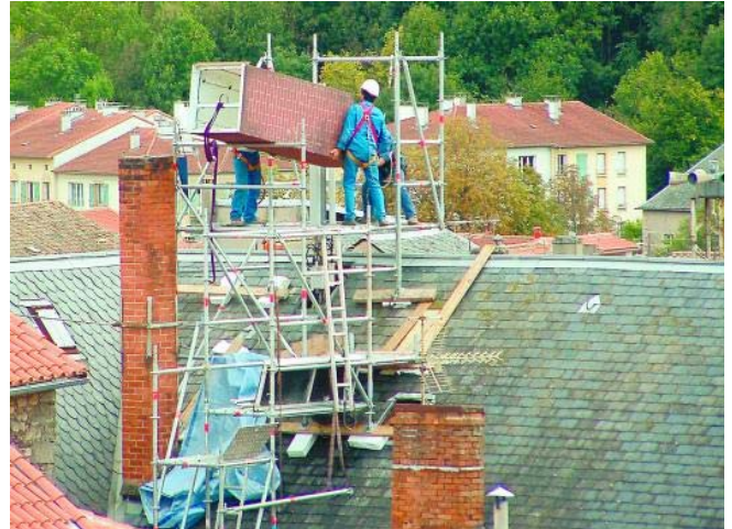
L'antenne-relais Orange, sur le toit de l'immeuble du 23, place de la Liberté, est dissimulée dans une fausse cheminée.
