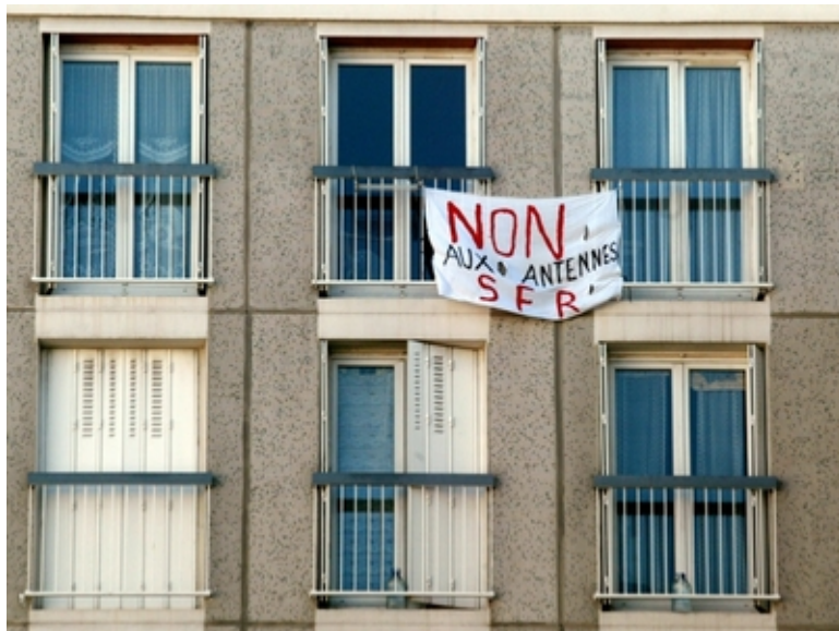
À Encagnane, les locataires dénoncent l'installation sans concertation d'antennes-relais sur les toits.
