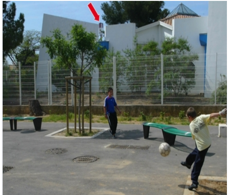
L'antenne-relais (voir flèche rouge) sur le toit de la maison de quartier des Pinchinades et tout près de l'école a été installée en juillet 2000. Le bail expirera le 30 juin 2009. © Serge Guéroult
