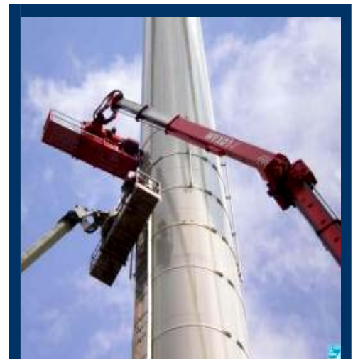
Les antennes relais téléphoniques seront installées sur les éoliennes.
