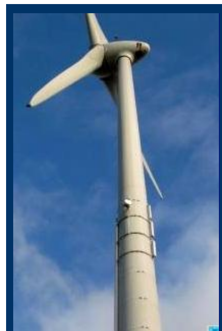
Six antennes - 2 par opérateur - ont été installées, à cinq mètres en dessous du bas des pales.
