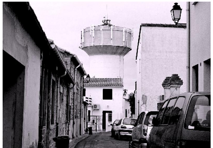
Des antennes relais ont été installées au sommet du Château d'eau de Villeneuve-de-la-Raho Photo JOURNAL L'INDEPENDANT
