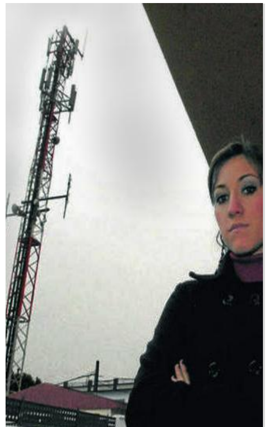
Une riveraine mère d'un élève du collège Manuel de Falla face au pylône des antennes relais de téléphonie mobile
