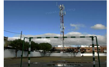
Le pylône d'antennes relais du collège Manuel de Falla de Brenes.
