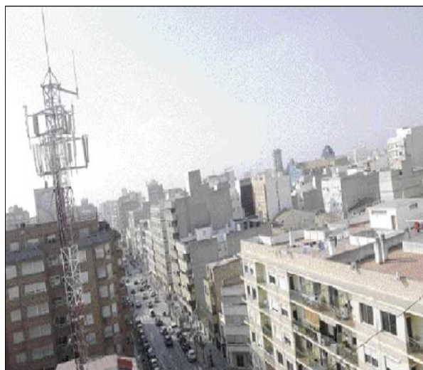
Avenue tárrega à Vila-real. L'antenne relais de téléphonie mobile est située dans sur le toit du central Téléphonique Ph.Carlos pascal
