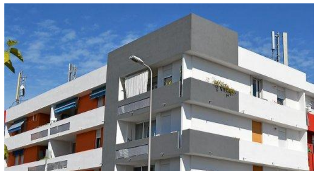
Les appareils ont été déplacés à la suite de travaux. Depuis, pour certains, les douleurs sont insupportables. (Photo M. B.)
