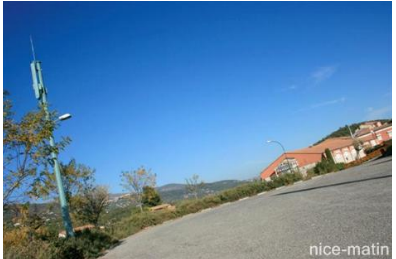
(ndlr de Next-up : photo précédent article ) L'antenne envoie ses ondes au-dessus de la mairie et de l'école dont les toits sont en contrebas. : Photo J.O.
