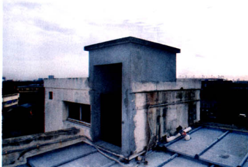
● Toit du 19 rue des Ursulines à Saint-Denis. Orange veut y planter une antenne mais les riverains s'y opposent.
