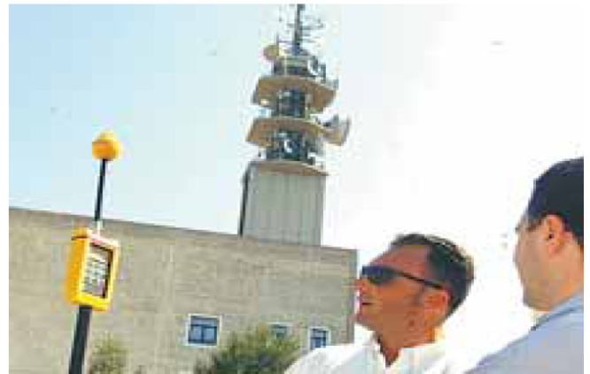
Medición de las radiaciones de una antena.
