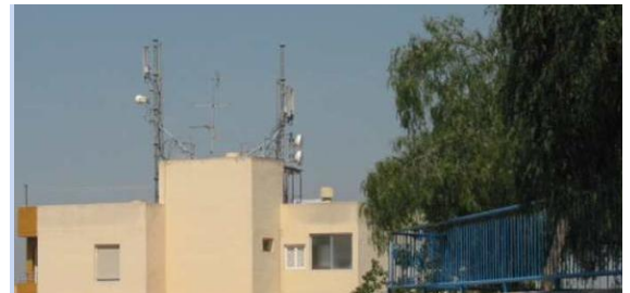
Antennes relais à côté de la garderie municipale de Rojales.
