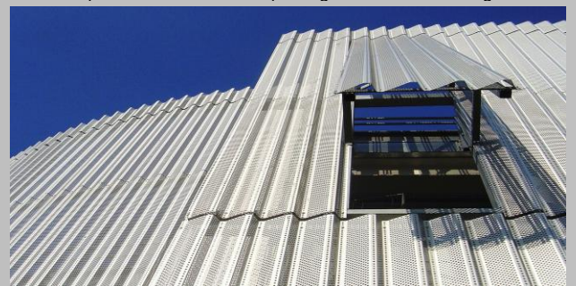
Vue détail de l'habillage des façades par des panneaux métalliques sur la structure du parking du métro station Argoulets à Toulouse.
