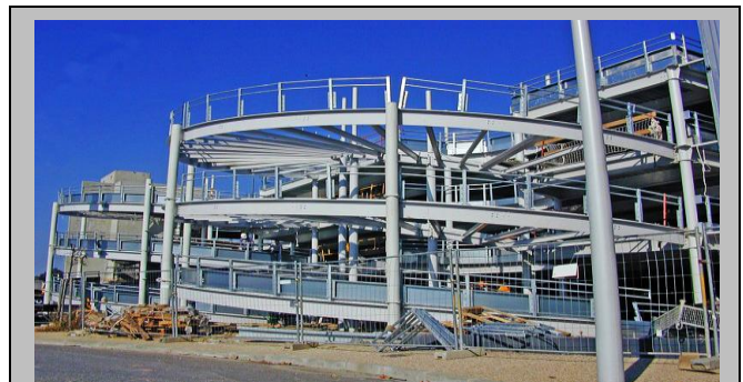
Vue fin de chantier de la structure de 520 tonnes d'acier du parking du métro station Argoulets avant son habillage métallique.
