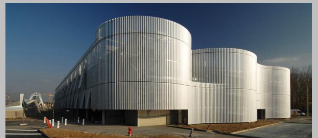
Vue fin de chantier avec la pose en façade de 2 270 m 2 de panneaux métalliques sur la structure du parking du métro station Argoulets.
