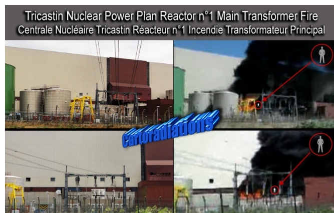
Photos incendie transformateur : Pas un seul intervenant in situ
