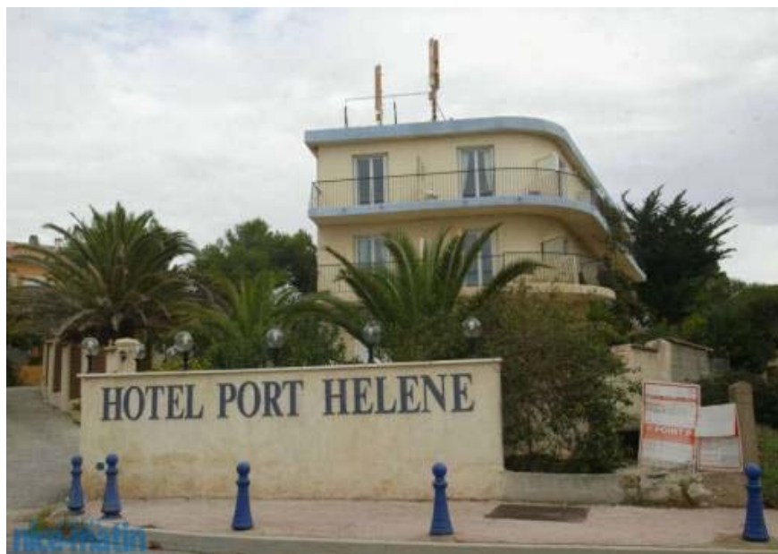
Après l'arrêt du chantier mercredi soir, riverains et le CIL réaffirment leur opposition à l'installation de nouvelles antennes relais Photo : L.M.
