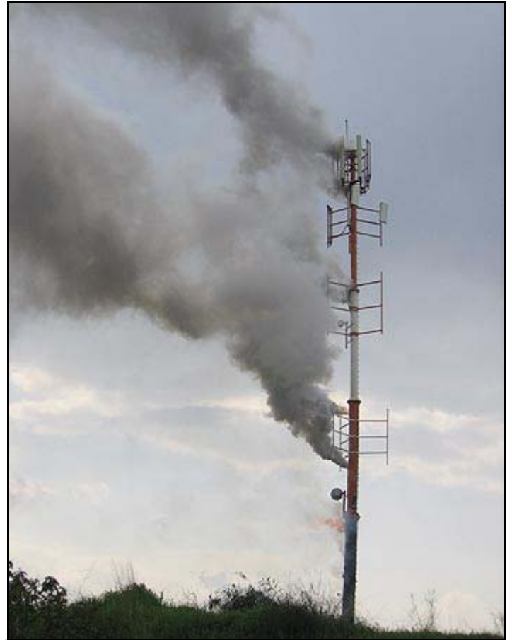
L'incendie du pylône d'antennes relais de TM
