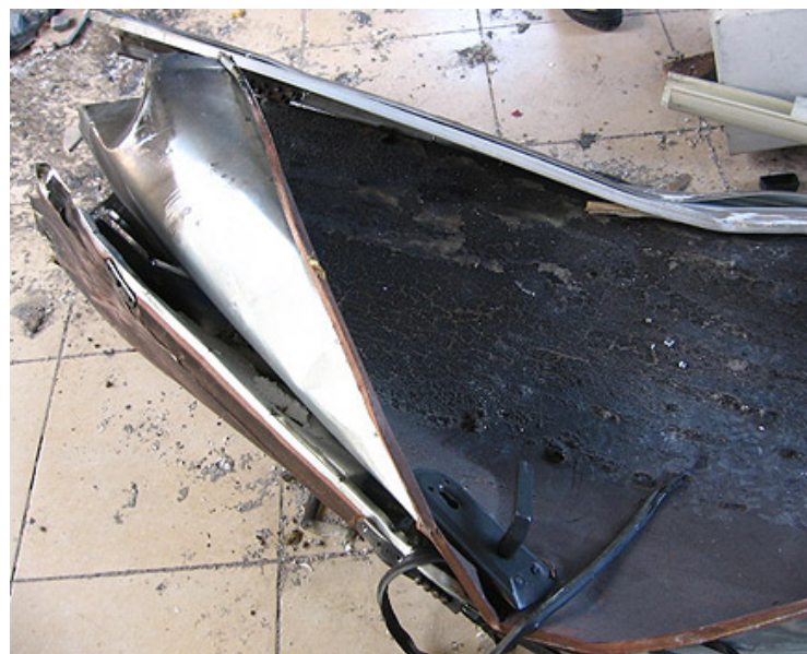
Une des portes qui a été soufflée par l'explosion
