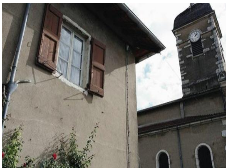
Le clocher du presbytère de Saint-Etienne-du-Bois héberge un site d'antennes relais camouflées
