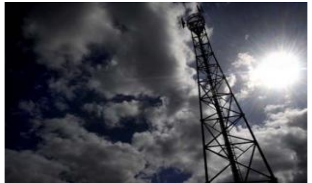
L'État avait autorisé en 2007 un opérateur de téléphonie mobile à installer et exploiter six émetteurs d'ondes électromagnétiques supplémentaires dans la commune de Crauthem.
