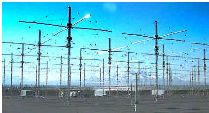
Photo 1. Ionospheric Research Instrument (IRI): vue partielle du réseau d'antennes d'émission et des shelters contenant les générateurs.
