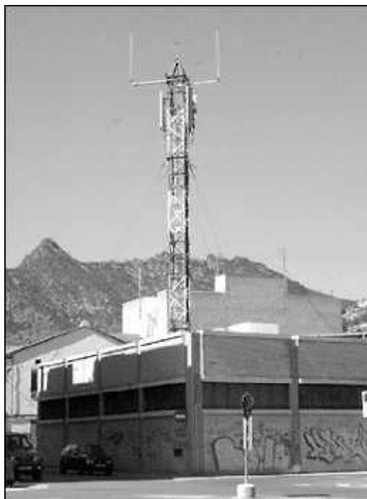
POLÉMIQUE. L'antenne se dans un bâtiment de Téléphonique depuis 1995.
