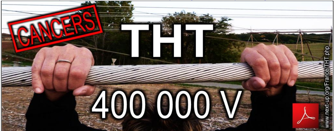
France : Câble aérien de ligne THT 400 000 V (RTE)
